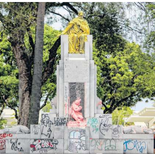
PICHACÕES e desgastes na obra
